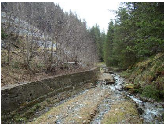
Fig. 5 Haldă de steril cu zid de protecție din perimetrul minier Suhărznel Mic.
