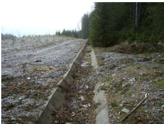
Fig. 4 Haldă de steril cu rigolă de evacuare a surplusului de apă din perimetrul minier Puiu.
