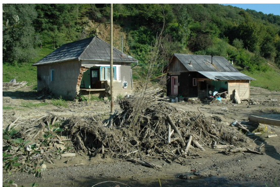
Fig. 9. Gospodării distruse de viitură pe Valea Izvorului.
