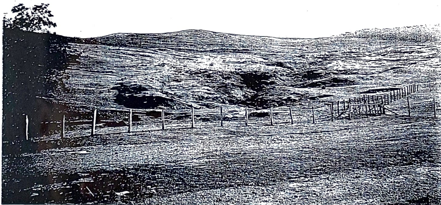
Foto 1. Torent instalat pe un corp de alunecare (localitatea Voinești)
