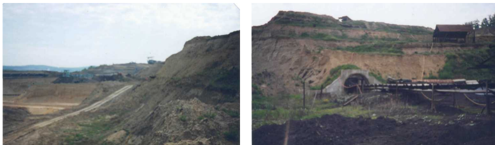
Fig. 3. Șiroire pe versanții lipsiți de vegetație – halda Valea Mănăstirii (a) și terenuri cu potențial apreciabil pentru activarea deplasărilor în masă (b). Rain wash on the slope without vegetation (Mănăstirii spoil bank) and places with important potential mass moving.
