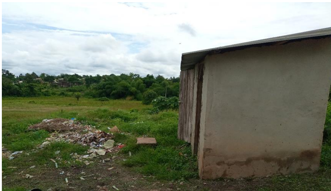
B) Devanture des toilettes de l'EPP Bangué 2 transformée en dépotoir d'ordure
