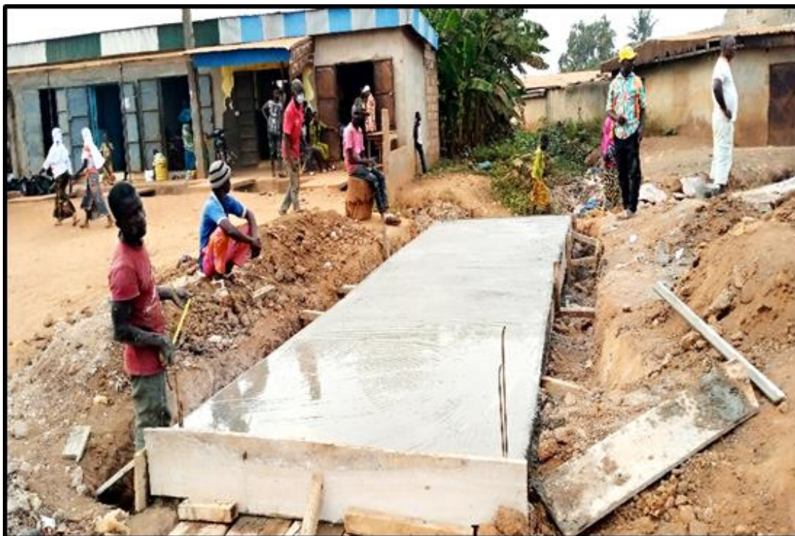
Photo 2 La réalisation du dalot au quartier Odiennékourani. Source: YEO B, 2022.
