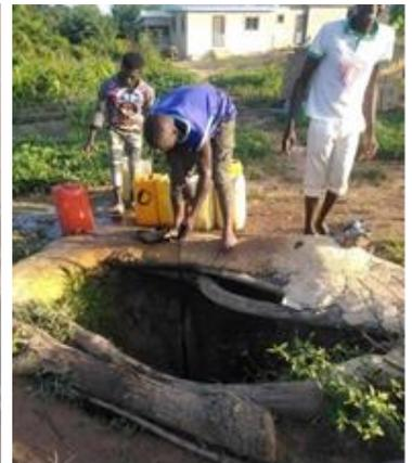
**Photo 6** Puits en état de dégradation.
