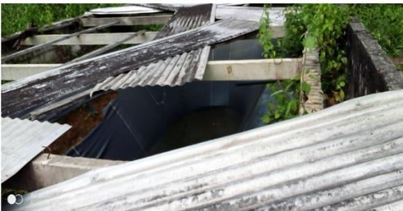
**Photo 5** Dégradation de la toiture de la citerne servant de collecte d'eau de pluie à Tsékampika (prise de vue : Prince Maba, janvier 2023).
